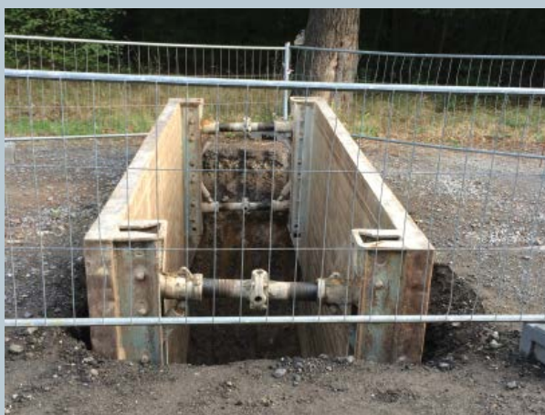
Stavební práce v Hodkovské začaly.
