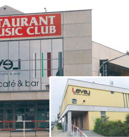
Polyfunkční dům a sál Level.
